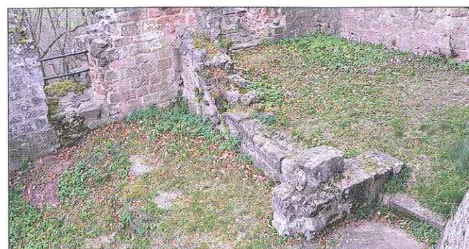
Novembre 2008: travaux autour de la courtine et dans le palais supérieur
